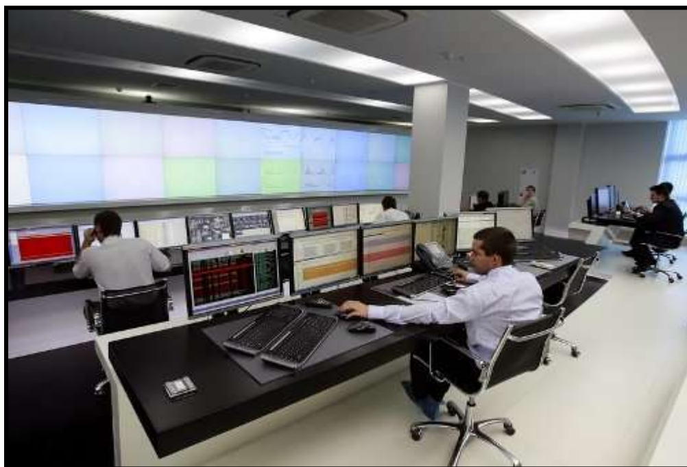
Современный data - центр
